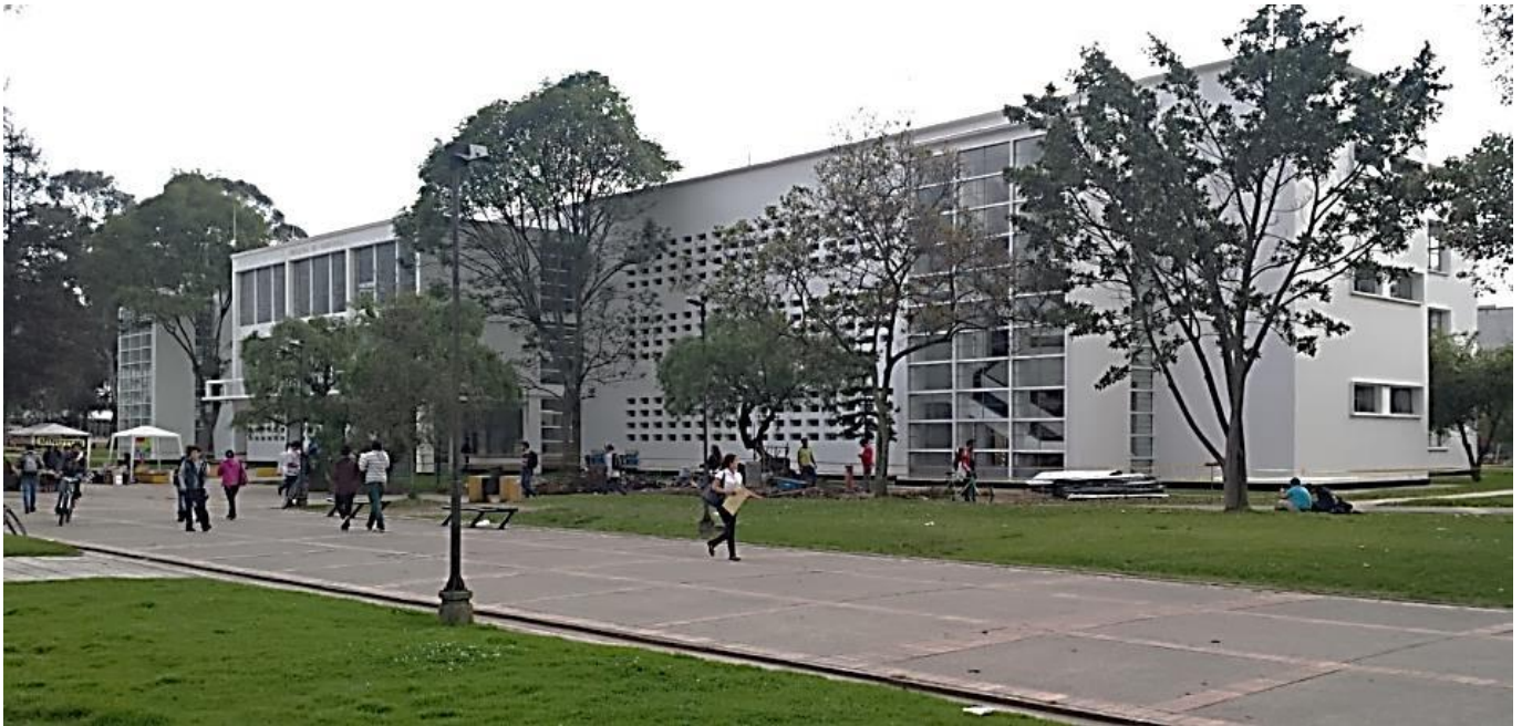
Ilustración 36. Vista norte del edificio en la actualidad. Fotografía CNM.
