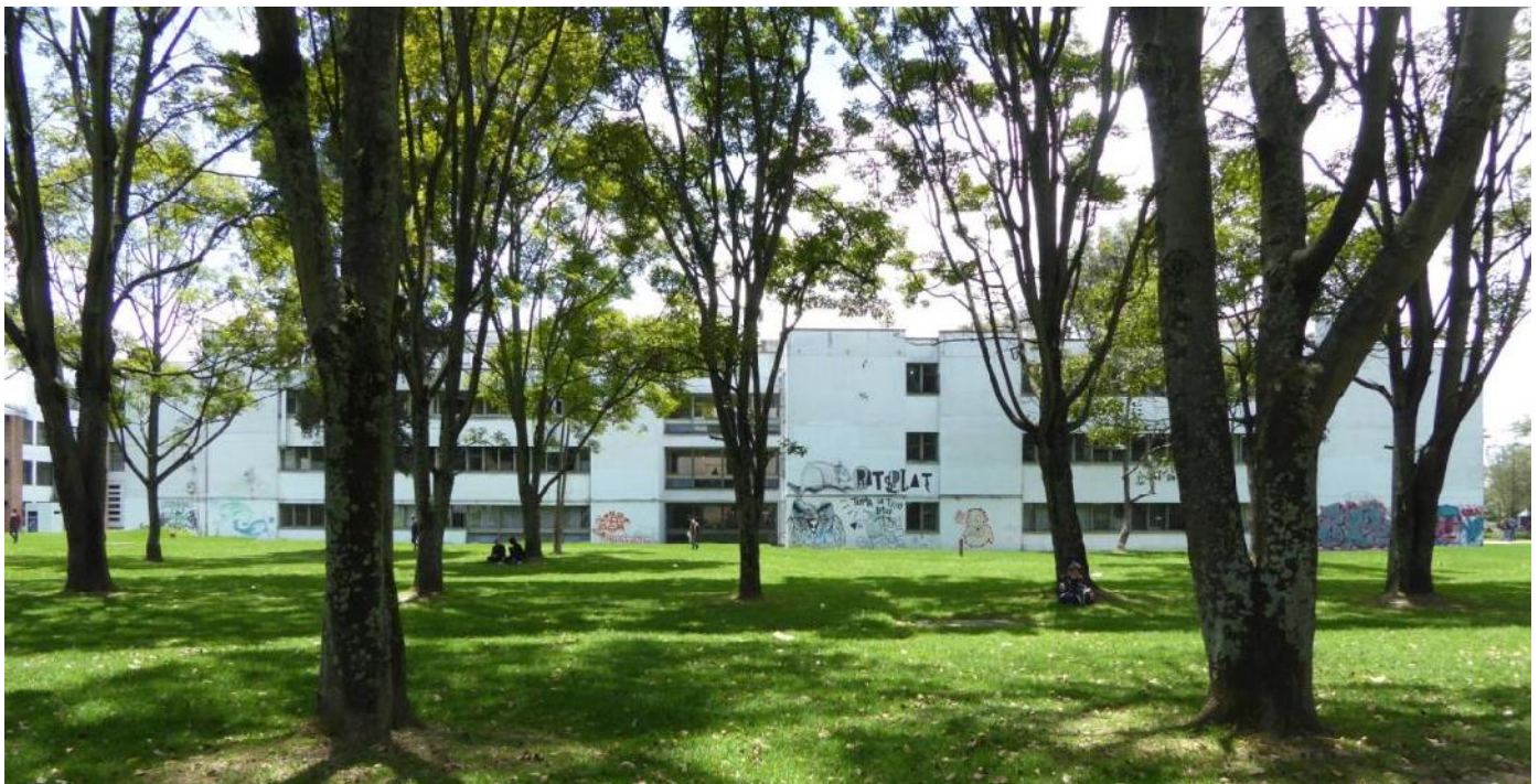
Ilustración 61. El malhadado edificio de Farmacia. Fotografía CNM.
