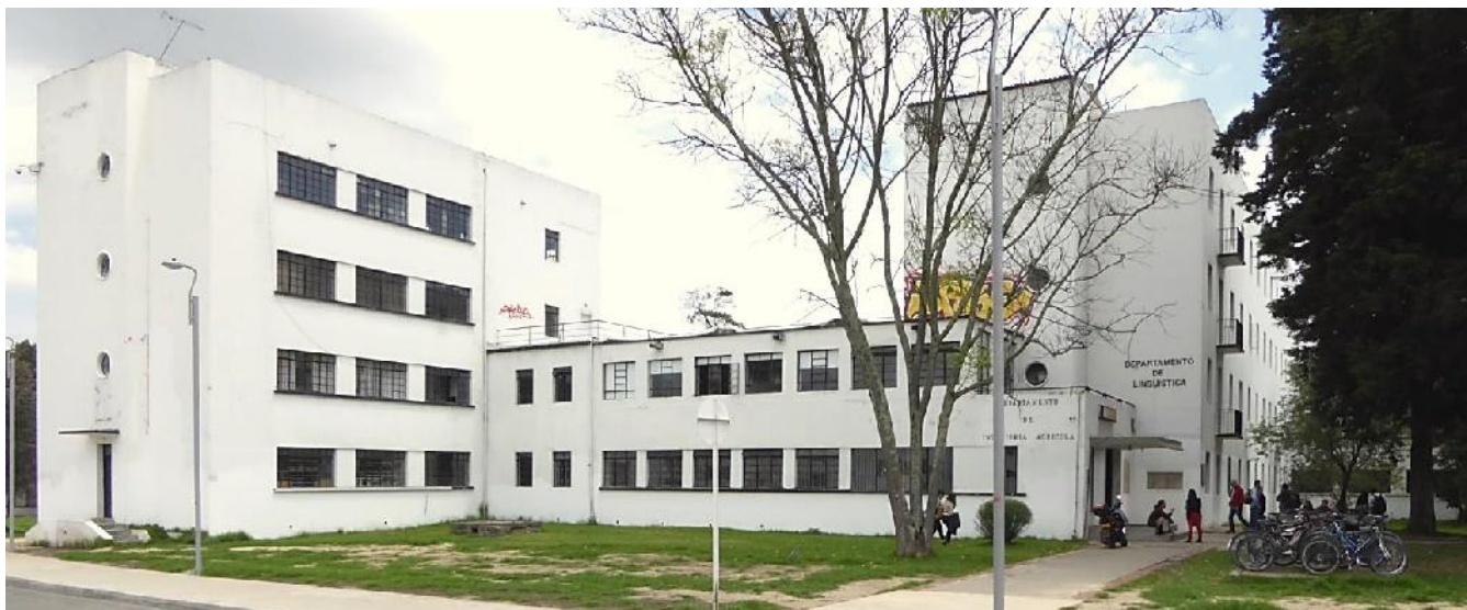
Ilustración 31. Vista actual del edificio. Foto CNM.
