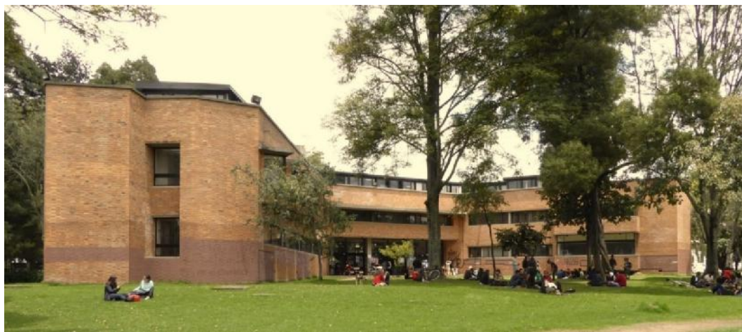
Ilustración 49 Edificio de Sociología. Fotografías CNM.
