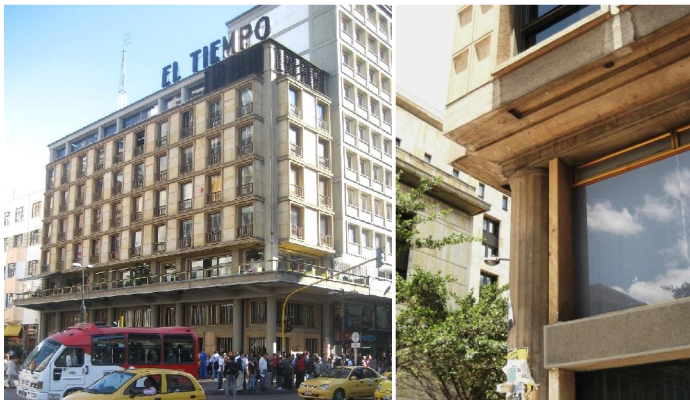
Ilustración 120. Bruno Violi, Edificio El Tiempo, 1958 y Edificio Quintana, 1960, Bogotá. Fotografías CNM.
